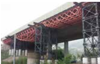
PONTE PROVVISORIO TANA Torrente Ribellasca, Camedo
