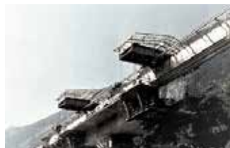
VIADOTTO SAN PELLEGRINO Autostrada A2, Giornico
