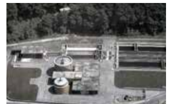
COLLETTORI E IMPIANTO DEPURAZIONE CMC Cadro
