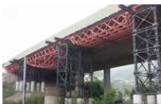
PONTE PROVVISORIO TANA Torrente Ribellasca, Camedo
