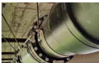
RISANAMENTO CANALIZZAZIONE PONTE TICINO Locarno
