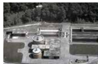
COLLETTORI E IMPIANTO DEPURAZIONE CMC Cadro
