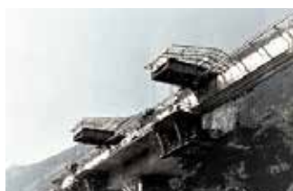
VIADOTTO SAN PELLEGRINO Autostrada A2, Giornico
