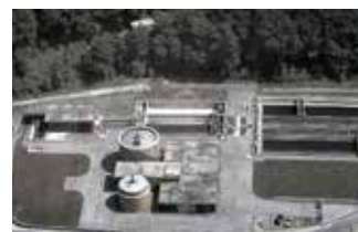
COLLETTORI E IMPIANTO DEPURAZIONE CMC Cadro
