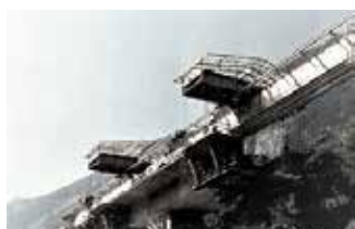
VIADOTTO SAN PELLEGRINO Autostrada A2, Giornico
