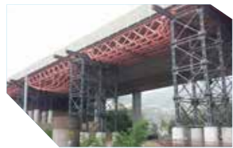
PONTE PROVVISORIO TANA Torrente Ribellasca, Camedo
