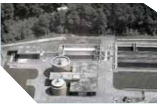
COLLETTORI E IMPIANTO DEPURAZIONE CMC Cadro
