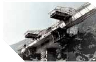
VIADOTTO SAN PELLEGRINO Autostrada A2, Giornico
