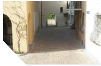
INFRASTRUTTURE NUCLEO Montagnola
