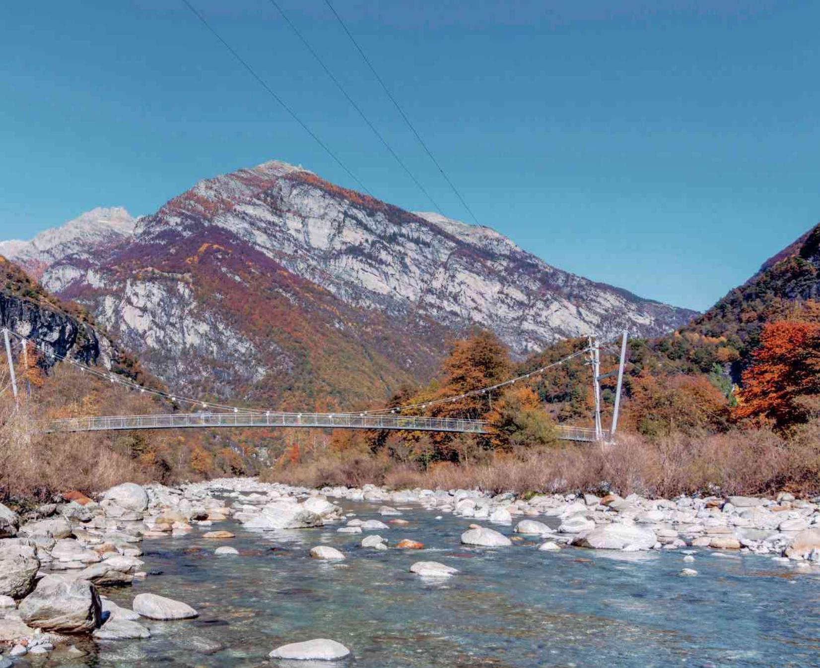
delle biciclette. Sottili orditure metalliche sospese da cavi sostengono un «tappeto di liste di legno». Il concetto strutturale si basa su un modulo unitario costituito da un telaio metallico che contiene il grigliato di legno. Questo modulo viene aggiunto e sostenuto in modi specifici in base alle diverse situazioni territoriali.
